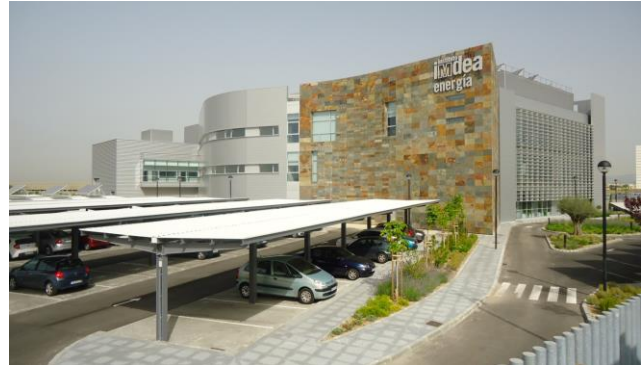
EDIFICIO IMDEA ENERGIA MOSTOLES (MADRID)
