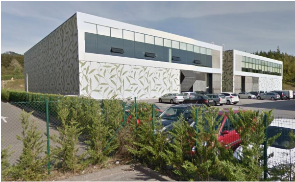
CENTROS DE INVESTIGACIÓN DE MICRODECO Y PIERBURG AMOREBIETA (VIZCAYA)
